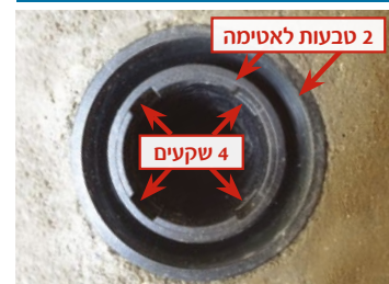
2 טבעות איתום בקצה הקונוס + 4 שקעים לאחיזת הרובה בשיטת ברנוביץ
