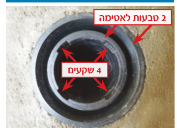
2 טבעות איתום בקצה הקונוס + 4 שקעים לאחיזת הרובה בשיטת ברנוביץ
